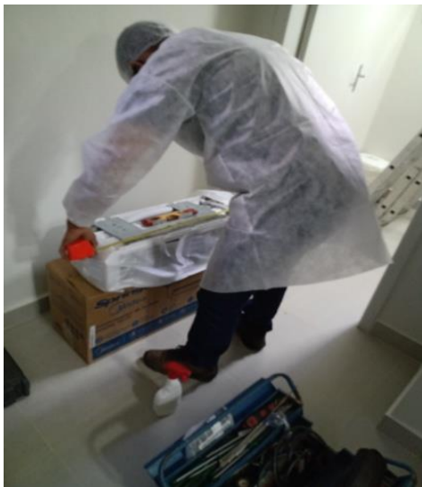
Instalação de Ar condicionado
