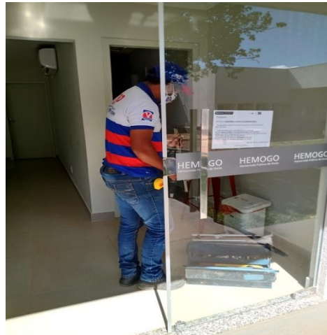
Manutenção Corretiva de porta
