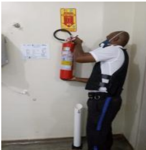
Troca de 04 extintores
