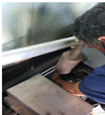
Figura 1. Manutenção do gerador
